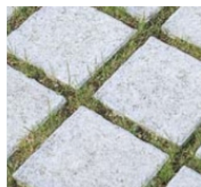
Pavés à joints ouverts
