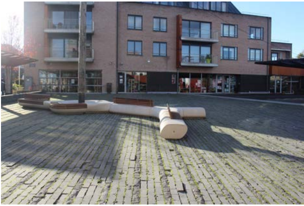
Embourg, Place André Musch : un revêtement irrégulier qui ne facilite pas la marche des PMR
