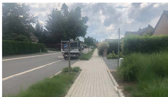
Exemple à favoriser : avant/après le réaménagement d'une voirie
