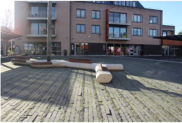
Embourg, Place André Musch : un revêtement irrégulier qui ne facilite pas la marche des PMR
