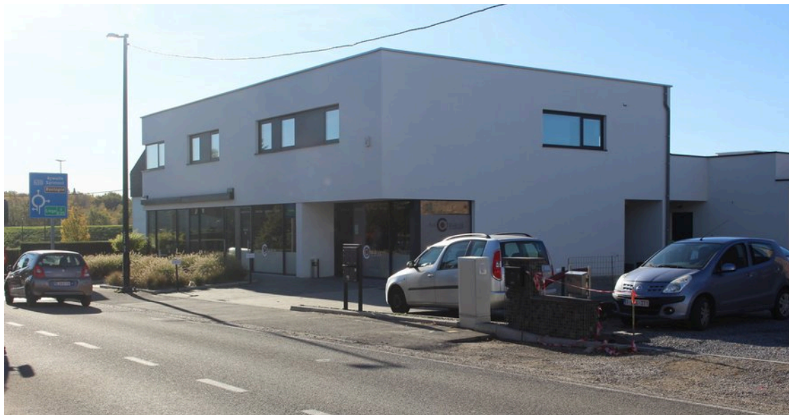
Beaufays – Rue Toussant Gerkens : une typologie de développement particulièrement destructurante à proscrire.
