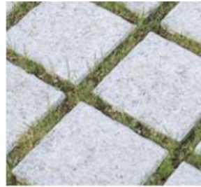
Pavés à joints ouverts
