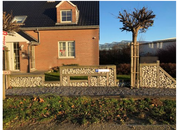
Exemple à éviter : gabions (Crédit photo : Pluris srl)
