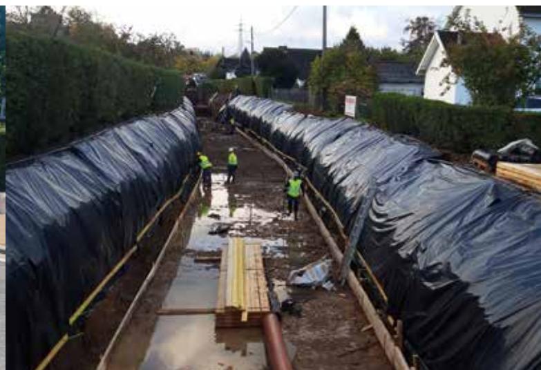
Les travaux des venelles ont commencé cet automne. ▲
