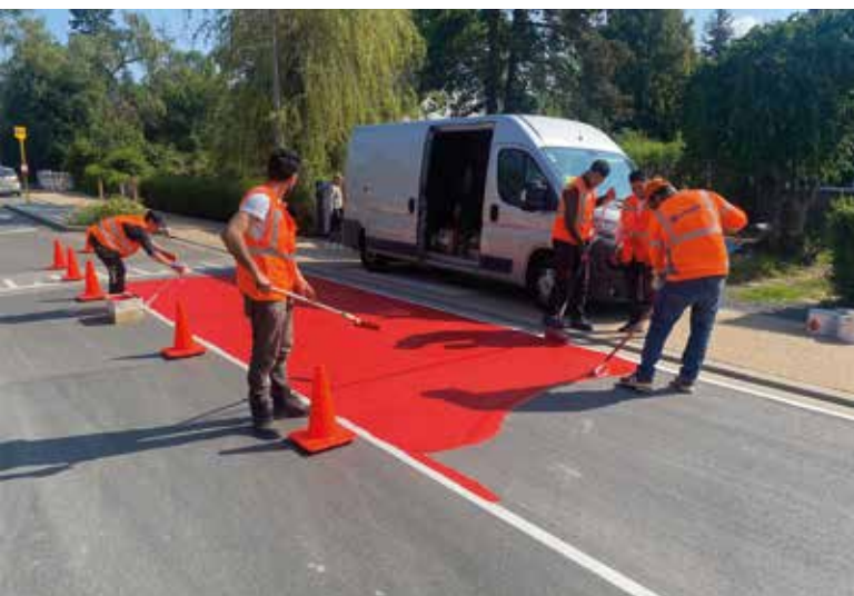
▲ Pose du tarmac rouge lors de la phase 1.
